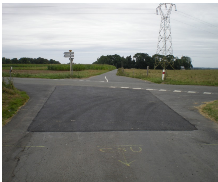
Travaux de reprofilage
