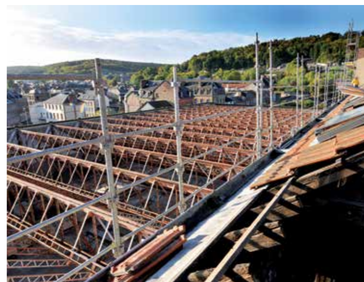
Travaux au niveau des toitures, 2008.
